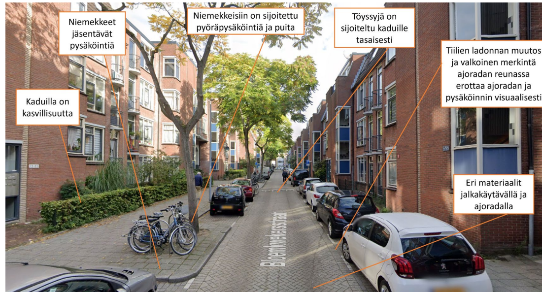
Kuvassa on esitetty Rotterdamin paikalliskaduilla (Snellinckstraat) käytettyjä liikenteen rauhoittamisen keinoja. Rotterdamissa pää- ja paikalliskatujen liikenne ympäristöjen välillä on selkeä ero. (Kuva: Google street view)
